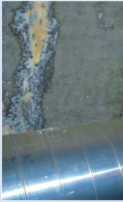
Risse und Ausblühungen an den Dichtungselementen der Tunnelsegmente
