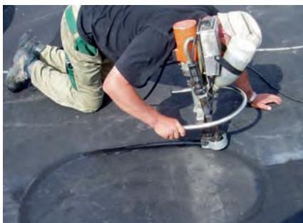
*Bild 5: Verschweißen der Bahnen mit dem Auftragsschweißverfahren*
