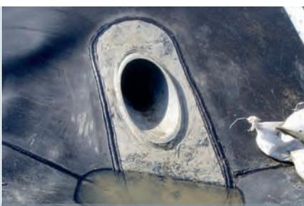
**Bild 7:** Anschluss der Kunststoffdichtungsbahn an ein Durchdringungsbauwerk mit Auftragsschweißnähten
