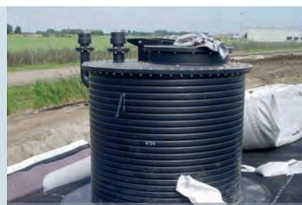
**Bild 8:** Anschluss der Kunststoffdichtungsbahn an den Kragen eines Gas-schachtes mit Auftragsschweißnähten
