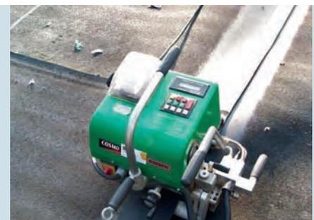
*Bild 6: Verschweißen der Bahnen mit einem Heizkeilschweißautomaten*
