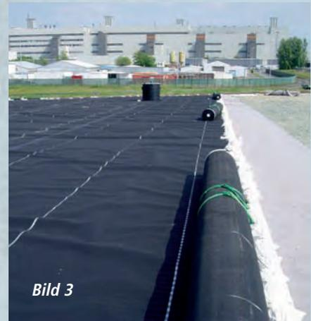
**Bild 1:** Verlegung der Kunststoffdichtungsbahn im Böschungsbereich zur Herstellung einer Basisabdichtung
