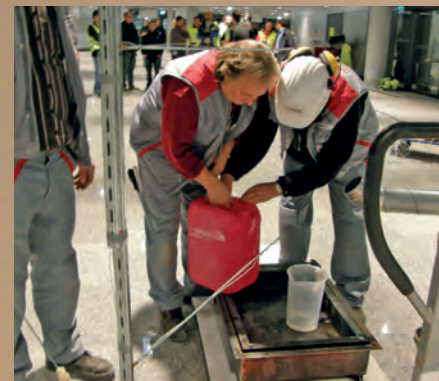
Befüllen der Brandwanne
