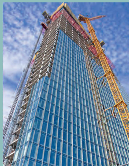
Baustand Sommer 2012: ca. 135 m geplante Höhe: 185 m
