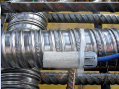
Einbau der in Braunschweig entwickelten, mit einer Mörtelschicht ummandelten Drahtsensoren zum Korrosionsmonitoring an den Faultürmen in Dresden.
