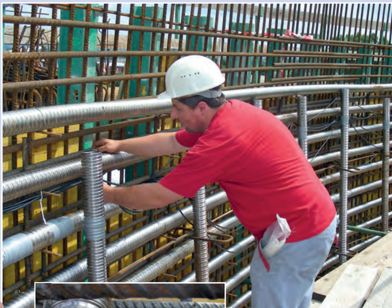
Einbau der in Braunschweig entwickelten, mit einer Mörtelschicht ummandelten Drahtsensoren zum Korrosionsmonitoring an den Faultürmen in Dresden.
