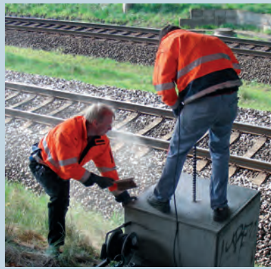
Die Wegaufnehmer wurden mit massiven Schutzrohren ummantelt
