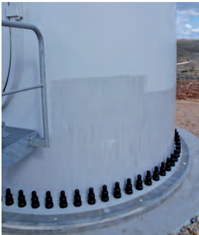
Mischungsfehler der Zweikomponenten-Beschichtung
