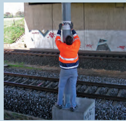
Die Wegaufnehmer wurden mit massiven Schutzrohren ummantelt
