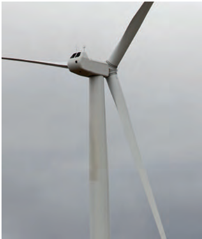
Braune Verfärbung der Beschichtung an den Stahltürmen
