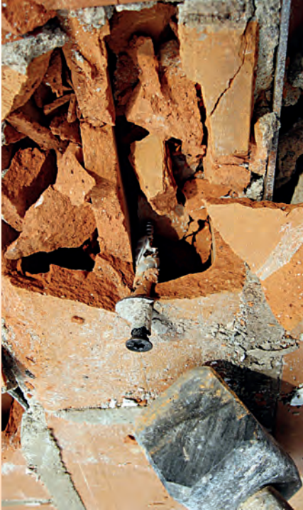
Beurteilung der Dübel nach dem Brandversuch durch Zerstören der Steine
