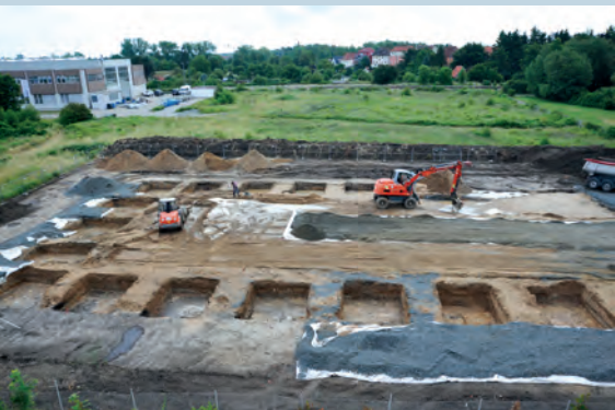
Aushub Stützenfundamente
