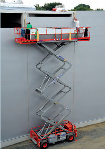
Montage der Sandwichplatten
