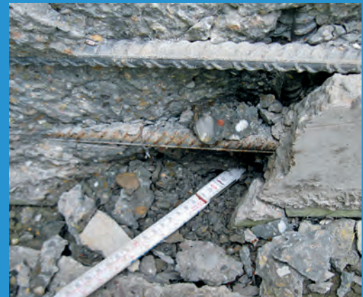
Freigelegte Betonstahlbewehrung
