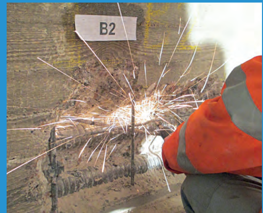
Entnahme von Spannstahlproben
