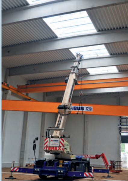
Montage der Krananlage
