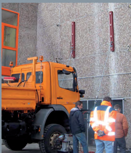
Probebelastung an einer Fassade mit LKW als Gegengewicht
