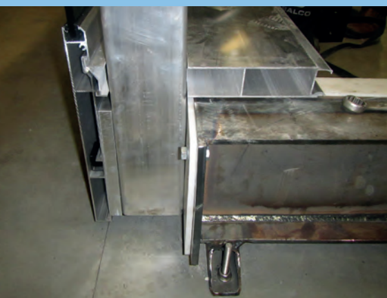
Detail der Anschlusskonstruktion des Brüstungselementes und dem Originaldeckträger von AIDAnova
