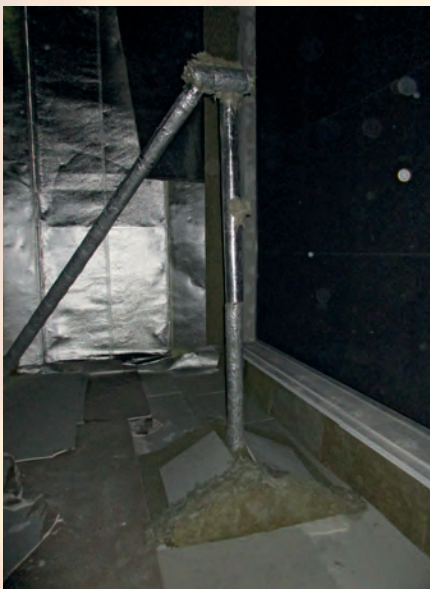
Strahlungsmessung am E90 Feuerschutzvorhang
