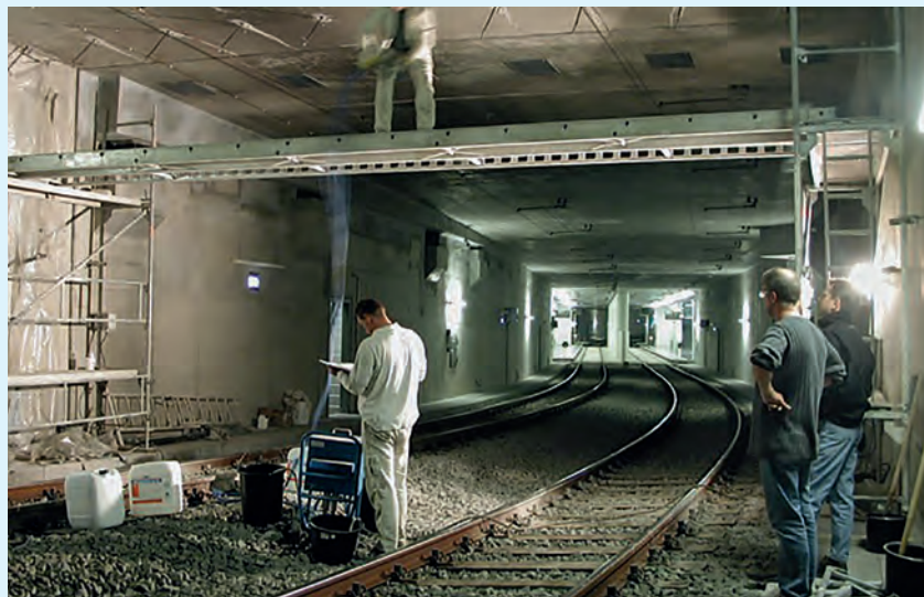
Bild 3: Injektion einer Bewegungsfuge in einem Staßenbahntunnel im Wand-, Boden-, und Deckenbereich
