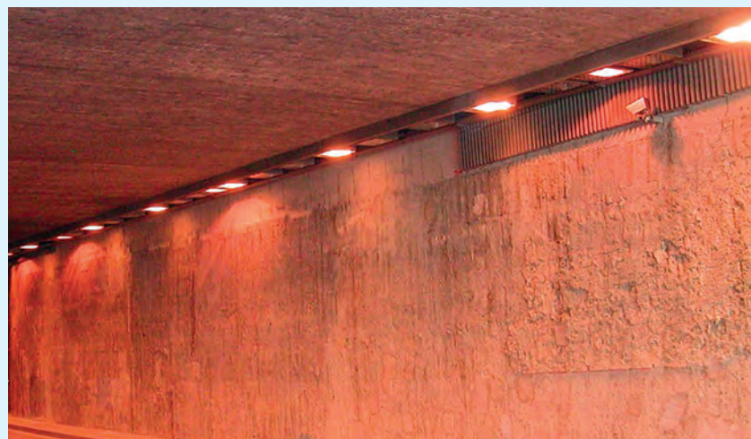
Bild 4: Tunnelbauwerk nach der Injektion der druckwasserführenden Pressfugen – dauerhaft dicht
