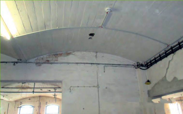
Beispiel einer Betonkappendecke in einem Fabrikgebäude
