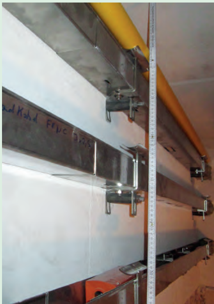
Kabelanlage der Firma Woertz AG vor der Brandprüfung
