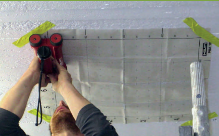
Flächenscan mit dem Ferroskan zur Ermittlung der Bewehrungslage
