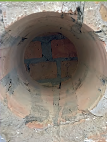
Entnahmestelle eines Bohrkerns Ø = 200 mm gewonnen zur Bestimmung der Festigkeit der Mauerwerksbaustoffe
