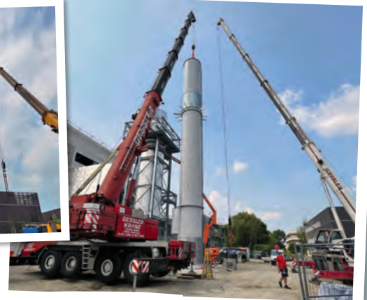
Beginn Aufbau der Rauchgasreinigungsanlage - Aufbau Verdampfungskühlturm + Kamin
