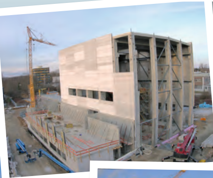
Aufbau Wandelemente - Beginn bis Fertigstellung
