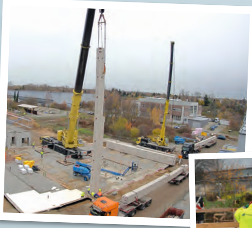
Anlieferung + Beginn des Aufbaus der 25 m hohen Stützen
