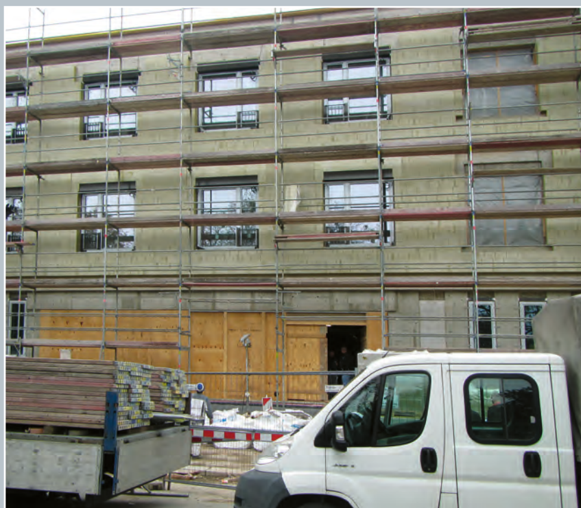
Abb. 3: Das Gebäude ist mit einer Wärmedämmung an der Außenseite der Fassade versehen. Die bereits montierten Fenster sind in der Wärmedämmebene befestigt.
