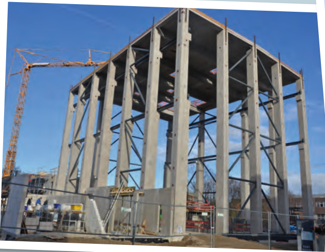
Aufbau Stützen bis Fertigstellung Grundgerüst
