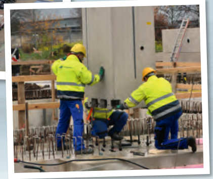
Anlieferung + Beginn des Aufbaus der 25 m hohen Stützen
