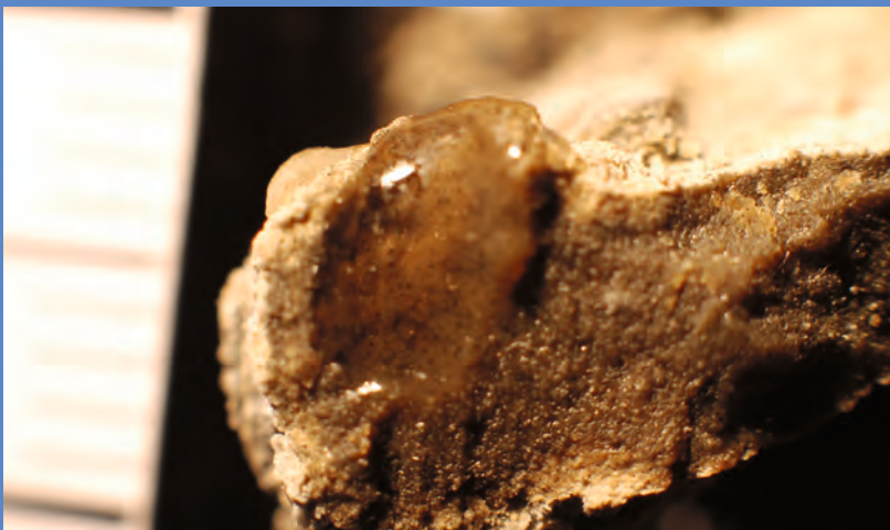
Abb. 4: AKR-Gel aus einem Bestandsbauwerk
