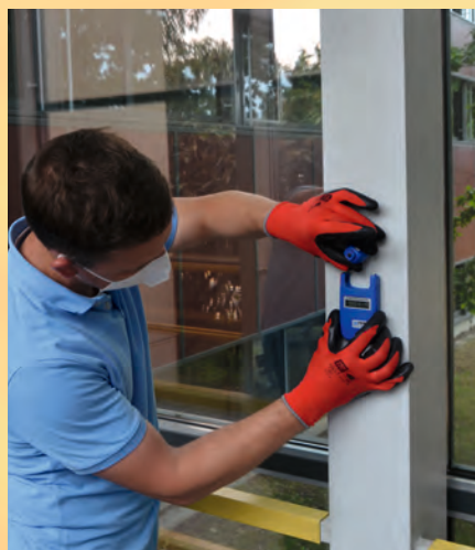
Schichtdickenmessung einer dämmschichtbildenden Brandschutzbeschichtung an einer Stahlstütze
