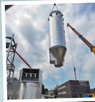
Beginn Aufbau der Rauchgasreinigungsanlage - Aufbau Verdampfungskühlturm + Kamin
