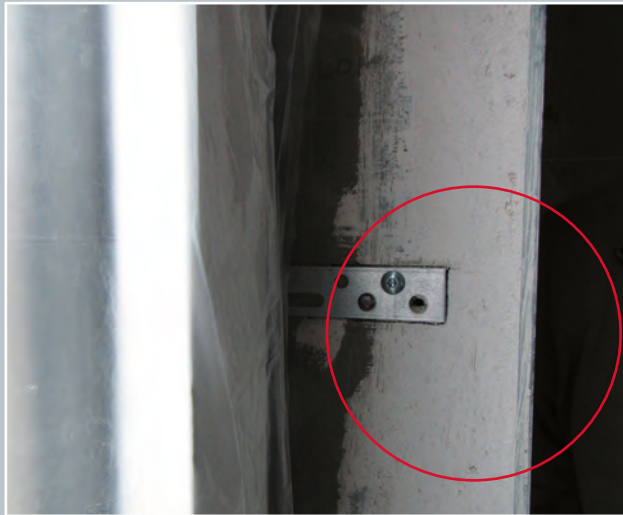
Abb. 1: Ansicht auf ein seitliches Befestigungselement (Stahllasche in dem roten Kreis) für die Vorwandmontage
