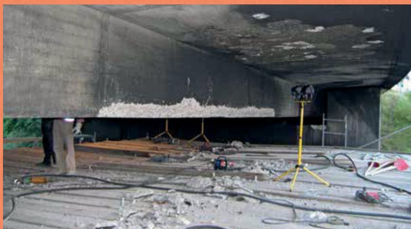
Abbildung 2: Vorgespannter Längsträger und Kragplatte einer Brücke nach LKW Brand. Lose abhaftende Abplatzungen wurden bereits mechanisch entfernt. [2]
