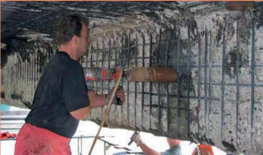
Abbildung 3: Anhaftende Betonteile werden mit dem Latthammer abgeschlagen (kleine helle Flächen), während die von Rissen hinterzogenen Kanten abgestemmt werden mussten.
