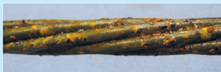
Detail der Spannstahlstange nach dem Versuch im oberen Bereich – Luft
