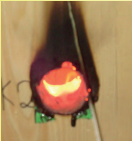
Bohrkernloch in einer Massivholzwand
