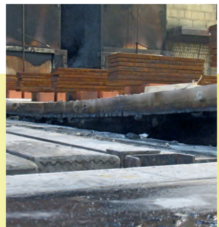
Massivholzdeckenplatte nach der Prüfung
